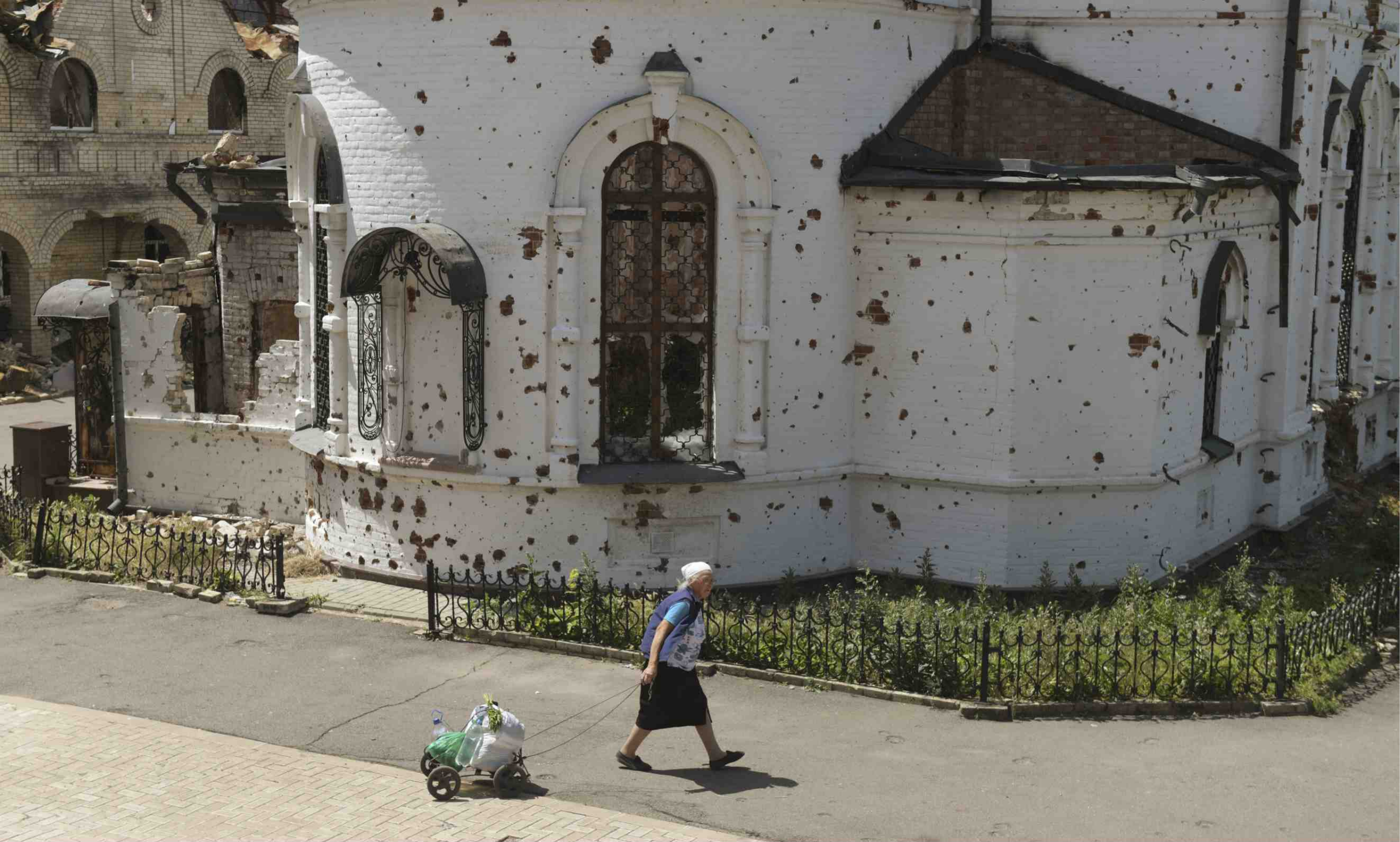
Разрушенный Васильевский храм в Свято-Успенском Николо-Васильевском монастыре в селе Никольское Волновахского района ДНР.
