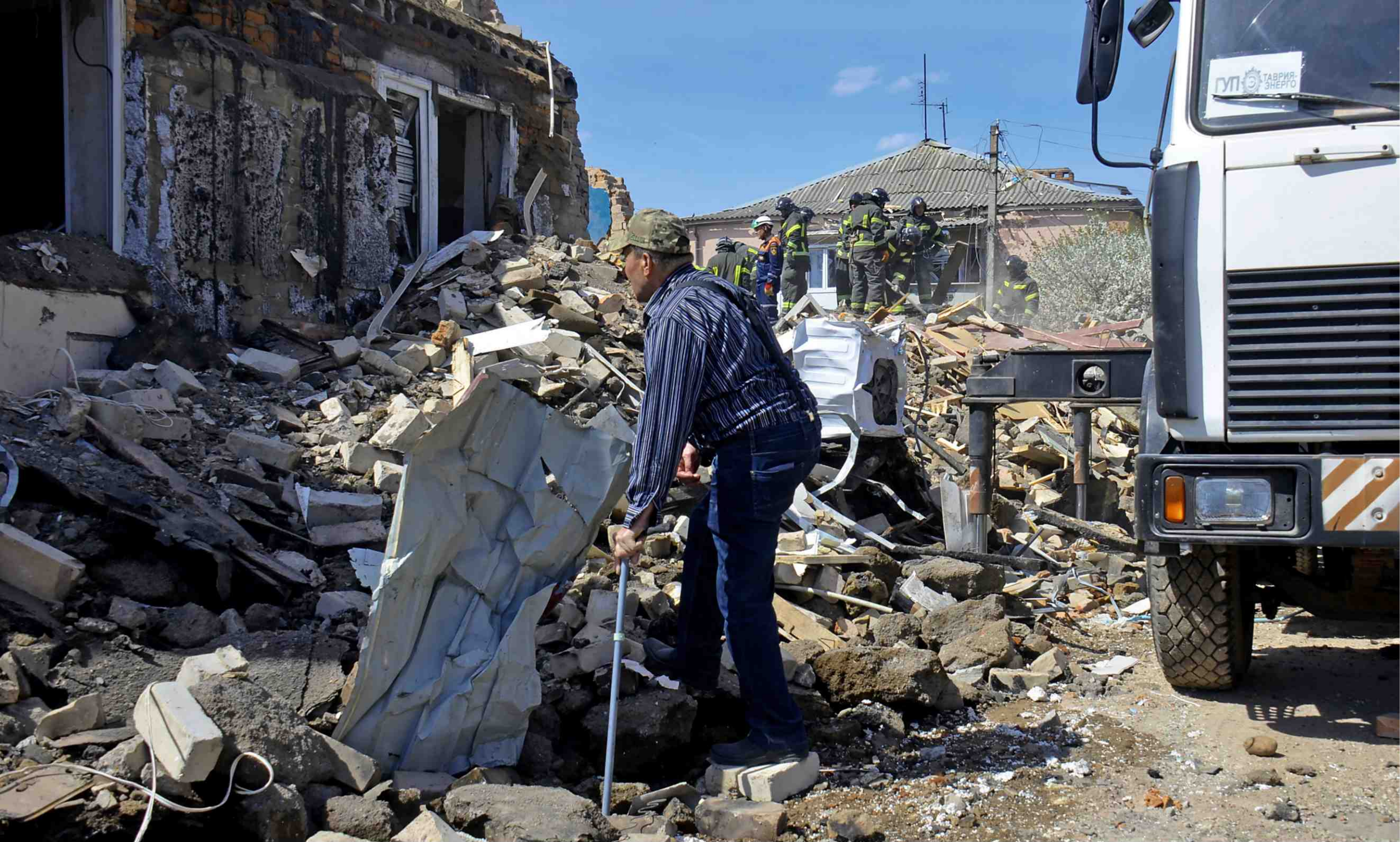
Многоквартирный дом в городе Токмак Запорожской области, частично разрушенный в результате обстрела ВСУ.
